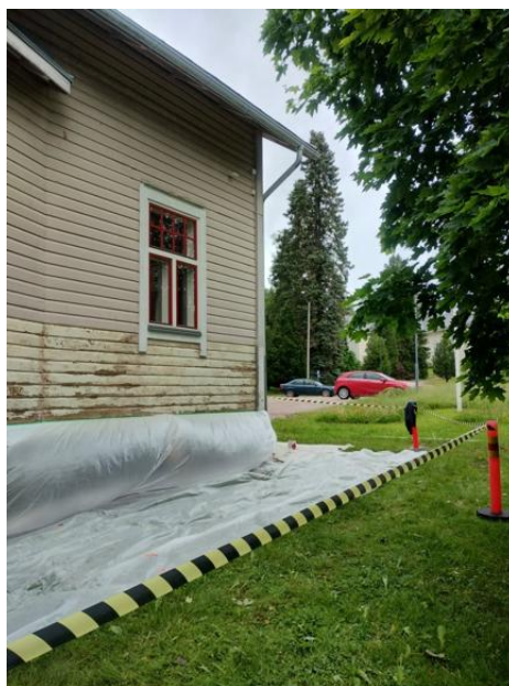
Ympäristö suojattu ja työskentelyalue rajattu.
