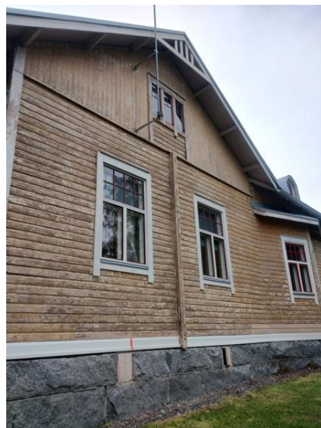
Julkisivu maalinpoiston jälkeen. Alapuu ja suurin osa pielilautoista uusittu aiemmin, ei vaadi maalinpoistoa.
