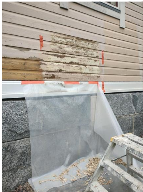
Maalinpoistotesti; Strip gel 15-20min vaikutusajalla.
