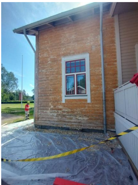
Suojauksia maalinpoistovaiheessa.
