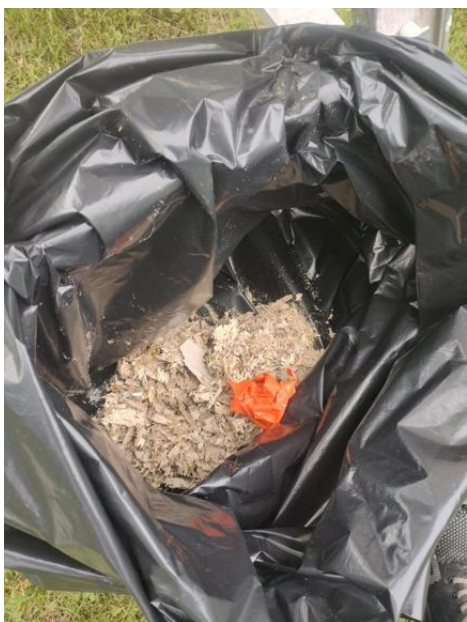
Irtoava maaliaines kerätty talteen hävitettäväksi.
