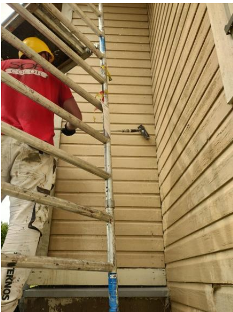
Homepesut harjaten. Kuvassa käynnissä laajennusosan pesut.
