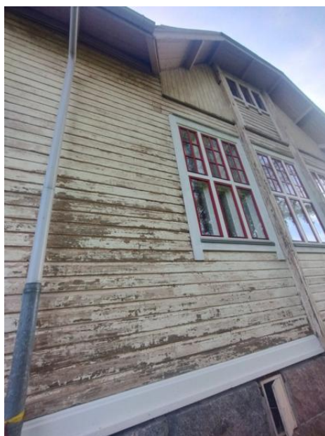
Maalinpoisto ensimmäisen kierroksen jälkeen.
