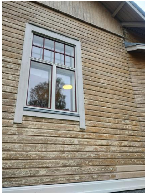
Seinä kevyesti hiottuna maalinpoiston ja pesun jälkeen ennen pohjamaalausta.
