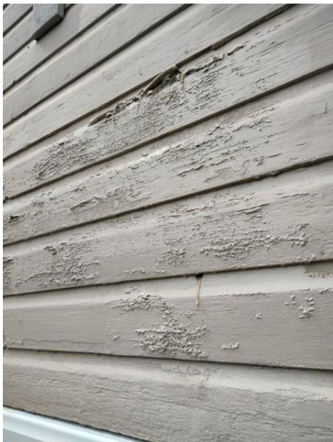
Strip Gel vaikuttamassa vanhalla maalipinnalla.
