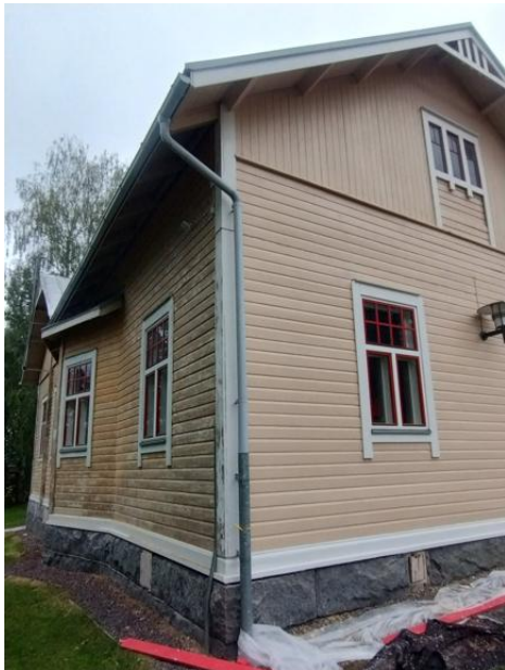
Pääty pohjamaalattuna (vasemmalla).
