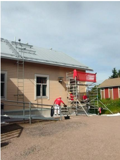
Laajennusosan etupuolen maalaustyöt käynnissä.
