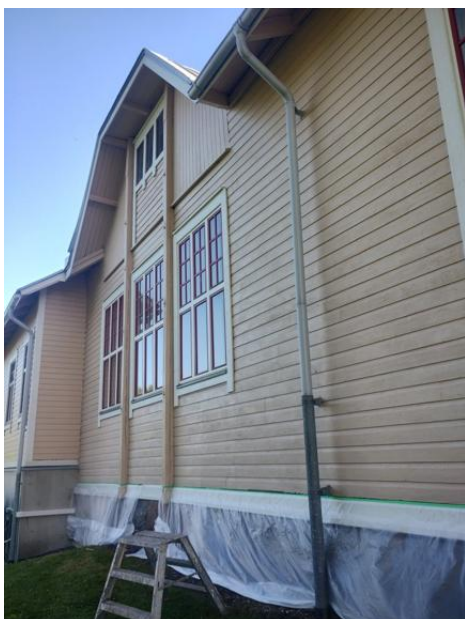
Vanhan osan seinää pohjamaalattuna.
