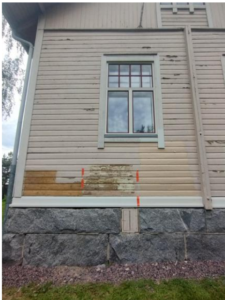
Maalinpoisto- ja testisävyt kadunpuoleisella seinustalla.
