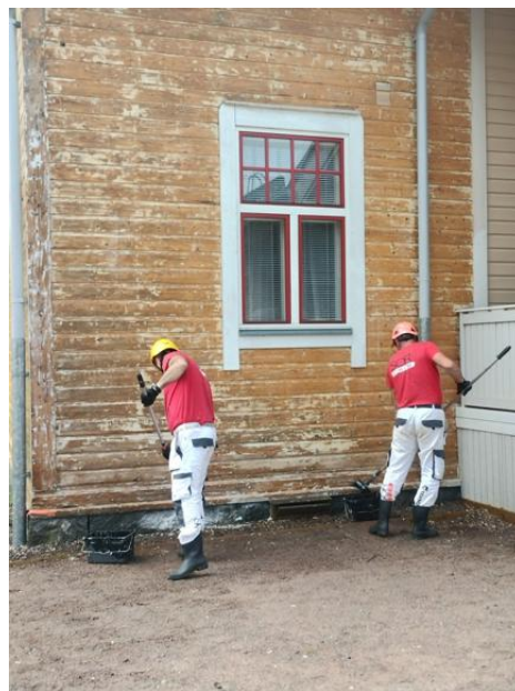
Seinän ja kivijalan pesua maalinpoiston jälkeen.
