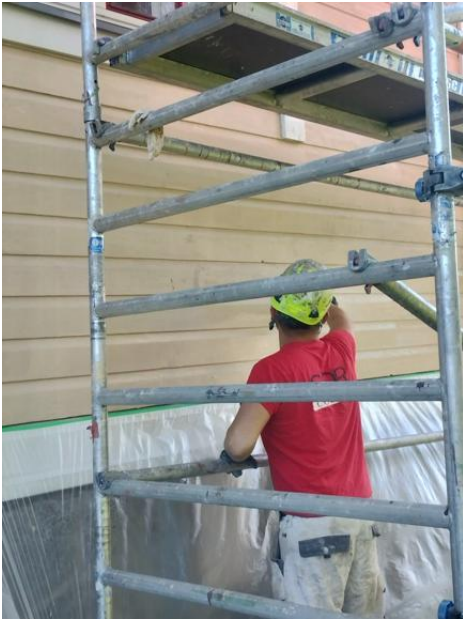
Vanhan osan pintamaalaustyöt käynnissä.
