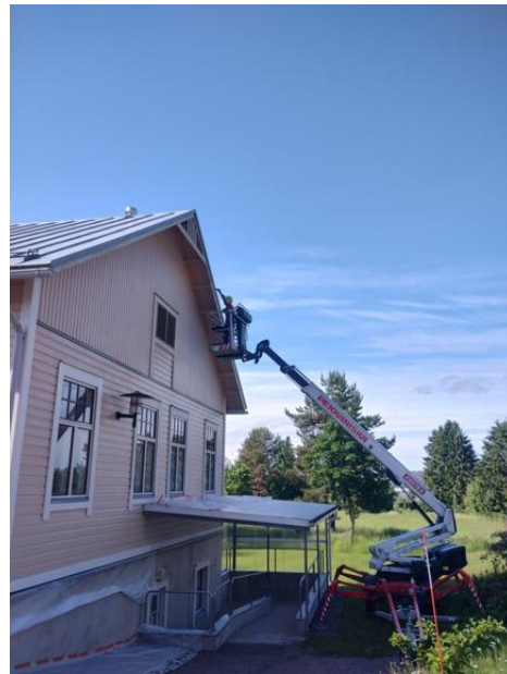
Laajennusosan päädyn maalausta nostimelta.
