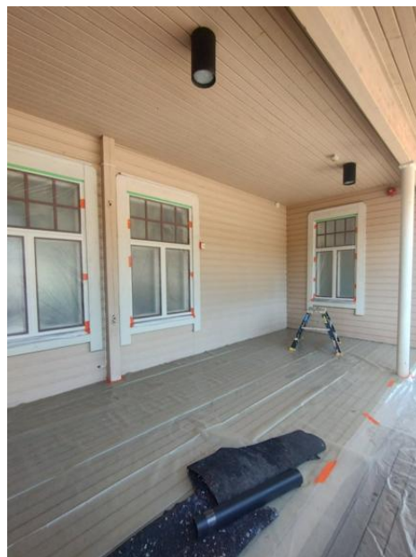
Suojauksia terassilla ennen maalausta.
