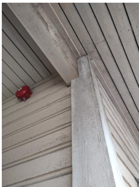
Terassilla runsaasti mustapilkkuhometta. Kuva ennen pesuja.
