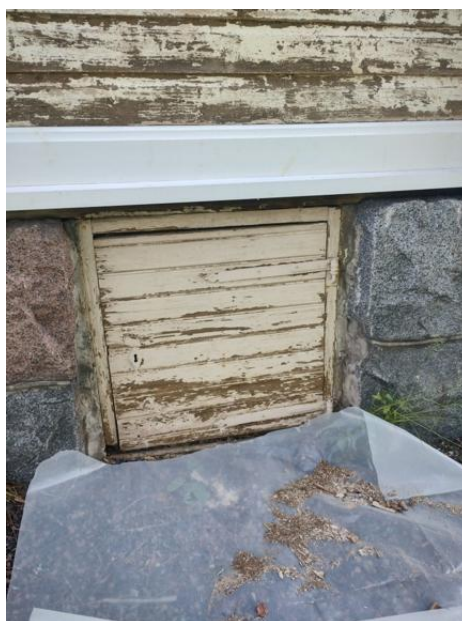
Tuuletusluukkujen mekaaninen maalinpoisto.
