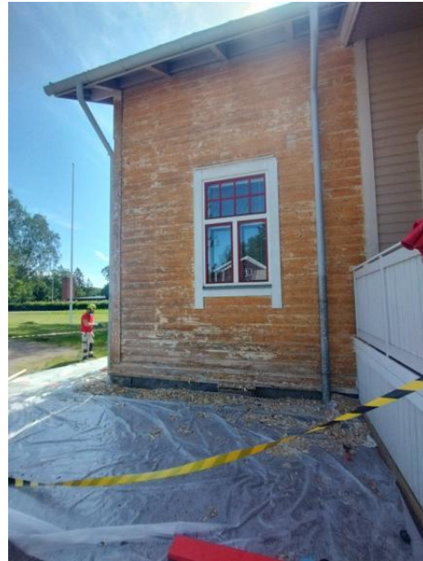
Seinäpintaa toisen maalinpoistokierroksen jälkeen.
