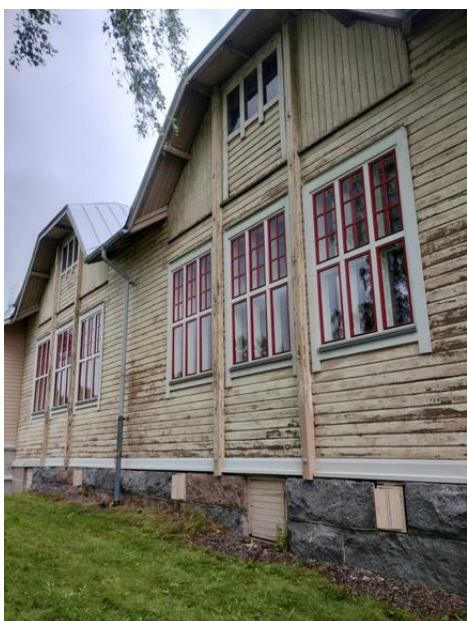
Maalinpoisto tehty, kuva ennen homepesua.
