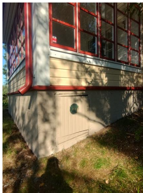
Sokkeli ja ryömintätilan luukku maalattuna.
