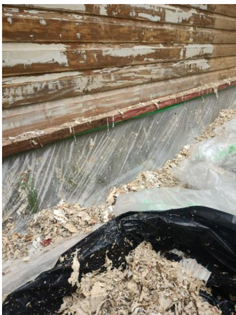
Irtoavan maaliaineksen kerääminen jätteisiin.
