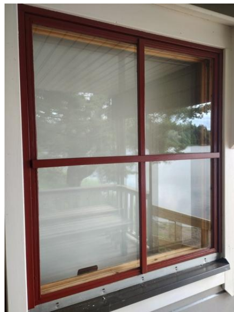
Saunan ikkuna karmilautoineen maalattuna.
