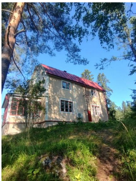
Rinteen puoleinen sivu maalaustöiden valmistuttua.
