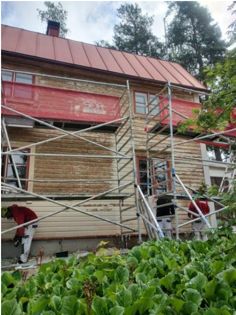
Maalinpoistotyöt käynnissä.
