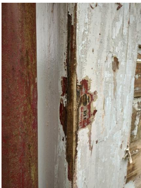
Maalikerrostumia päärakennuksen nurkkalaudoissa.
