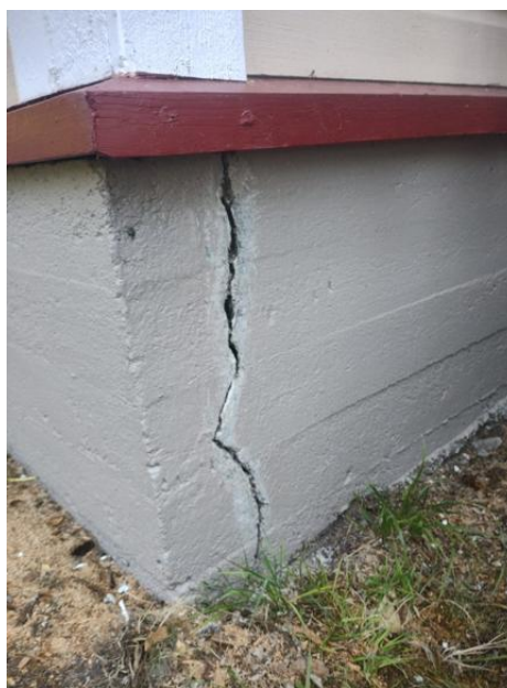
Sokkelin halkeamien puhdistus ennen betonikorjausta ja päällemaalausta.
