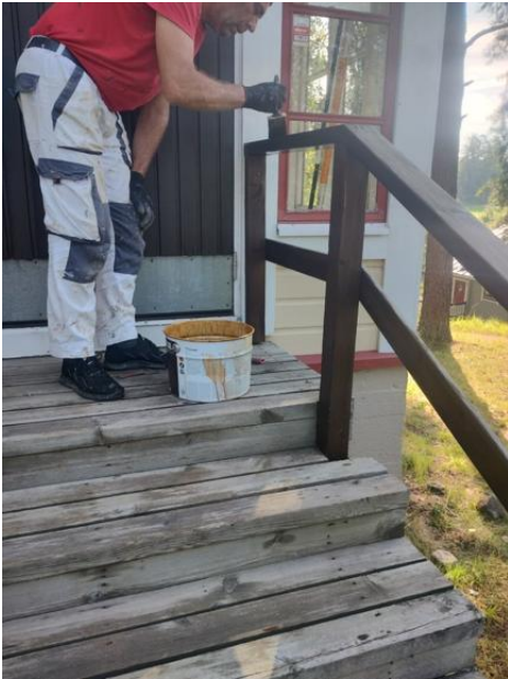
Päärakennuksen sisäänkäynnin puuportaiden öljyminen.
