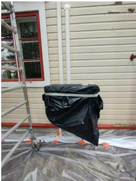
Esimerkki suojauksista ennen maalinpoistoa.
