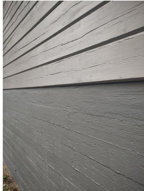
Saunan hirsiseinät ja sokkeli maalattuina.
