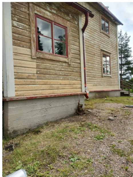
Päärakennus maalinpoiston jälkeen. Nurkkalaudat vielä käsittelemättä.
