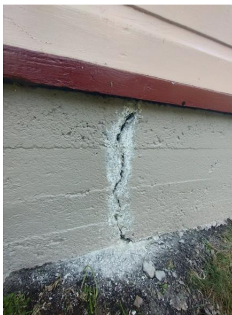
Sokkelin halkeamien puhdistus ennen betonikorjausta ja päällemaalausta.
