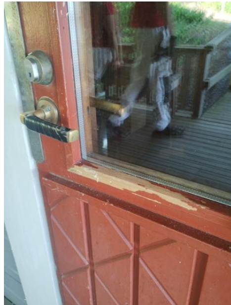
Pesujen jälkeen hilseilyttä maalia saunan ovesta.
