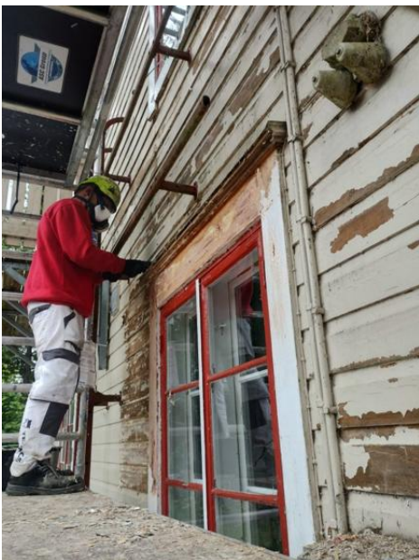
Maalinpoistotyöt käynnissä.
