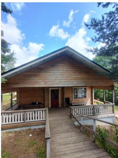
Saunalla maalinpoistotyöt tehtynä.
