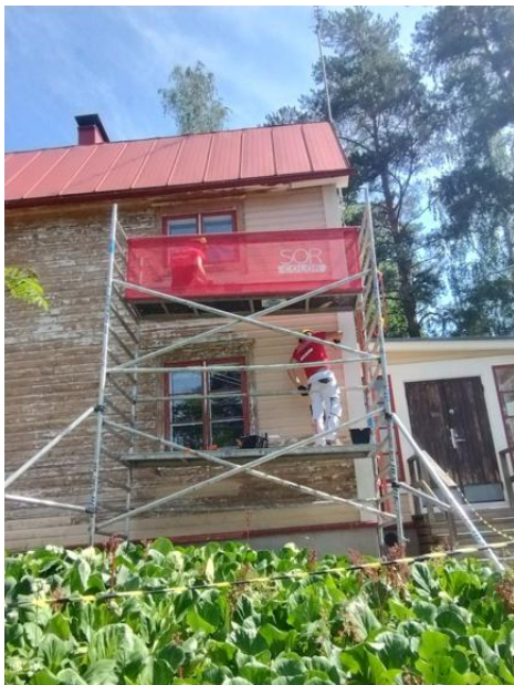
Päärakennuksen pohjamaalaukset käynnissä.
