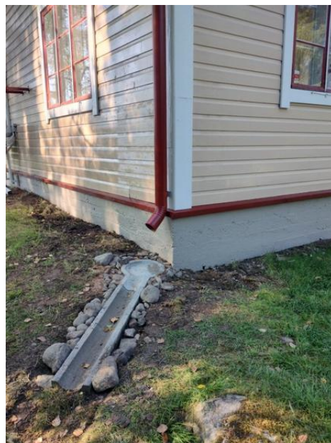
Sadevesikouru asennettuna päärakennukselle.
