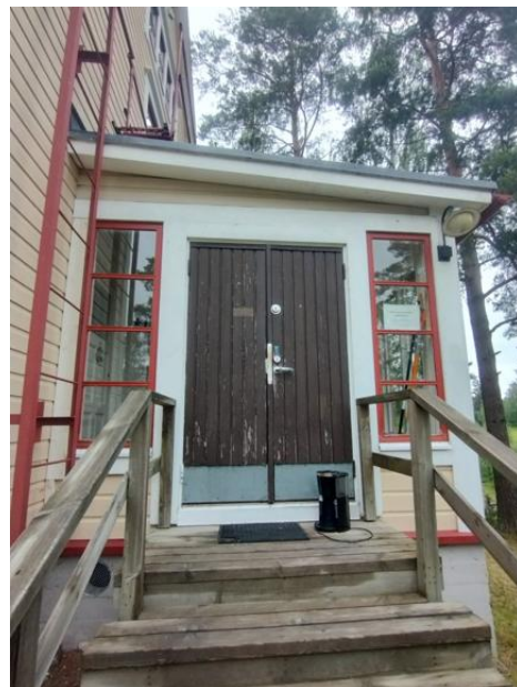
Pääovi ennen maalausta.
