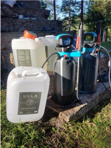
Pesun jälkeen homesuojaus.
