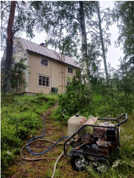
Katon pesutyöt käynnissä.
