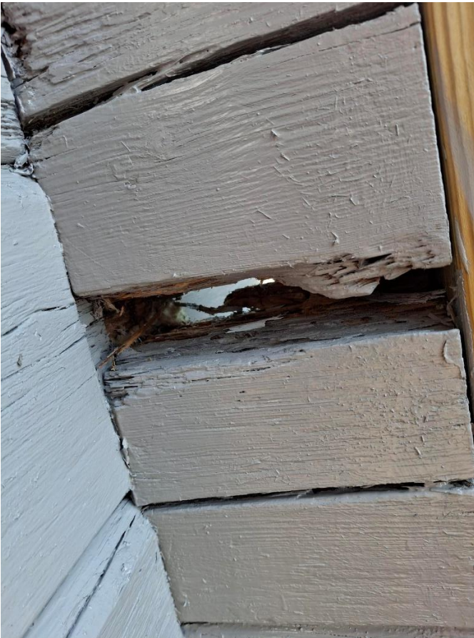
hirren lahokohta korjataan
