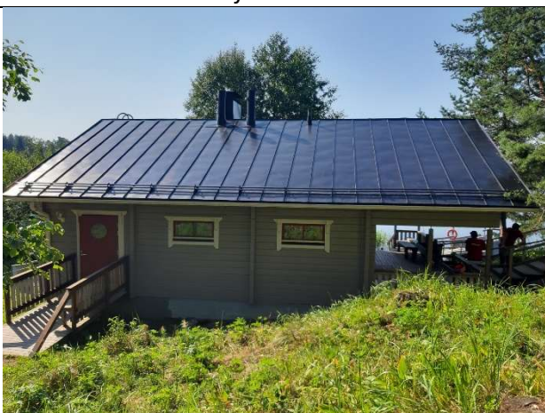
Yläsivun seinät maalattu
