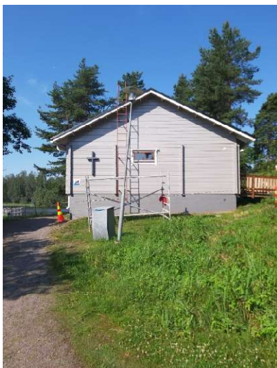
Sokkelin maalaus käynnissä
