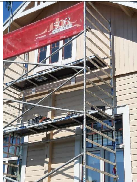
Ullakon ikkunoiden pokien maalaus ja kunnostus menossa.
