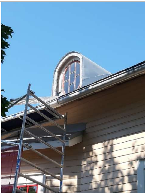
Kattolyhdyn ikkunan maalaus käynnissä
