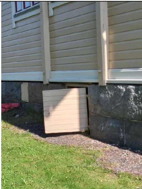
Rossipohjan luukut maalattu
