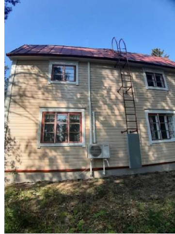
Seinät ja sokkeli maalattu
